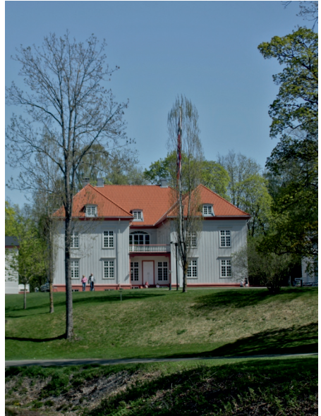
Norges viktigste? I Eidsvoll ligger iallfall én av vår kulturs viktigste bygninger.
